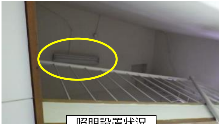
照明設置状況
