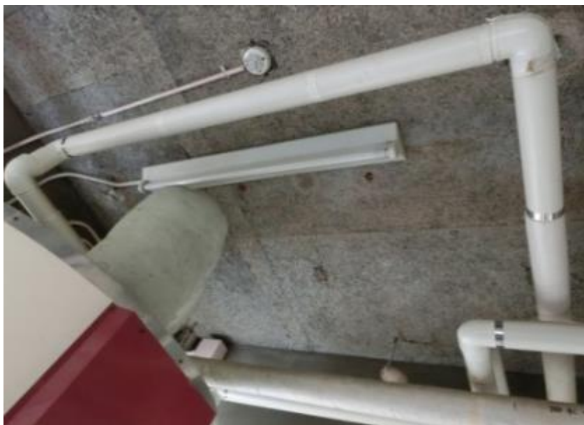
ボイラー上部
